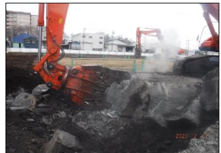
コンクリート圧碎作業
