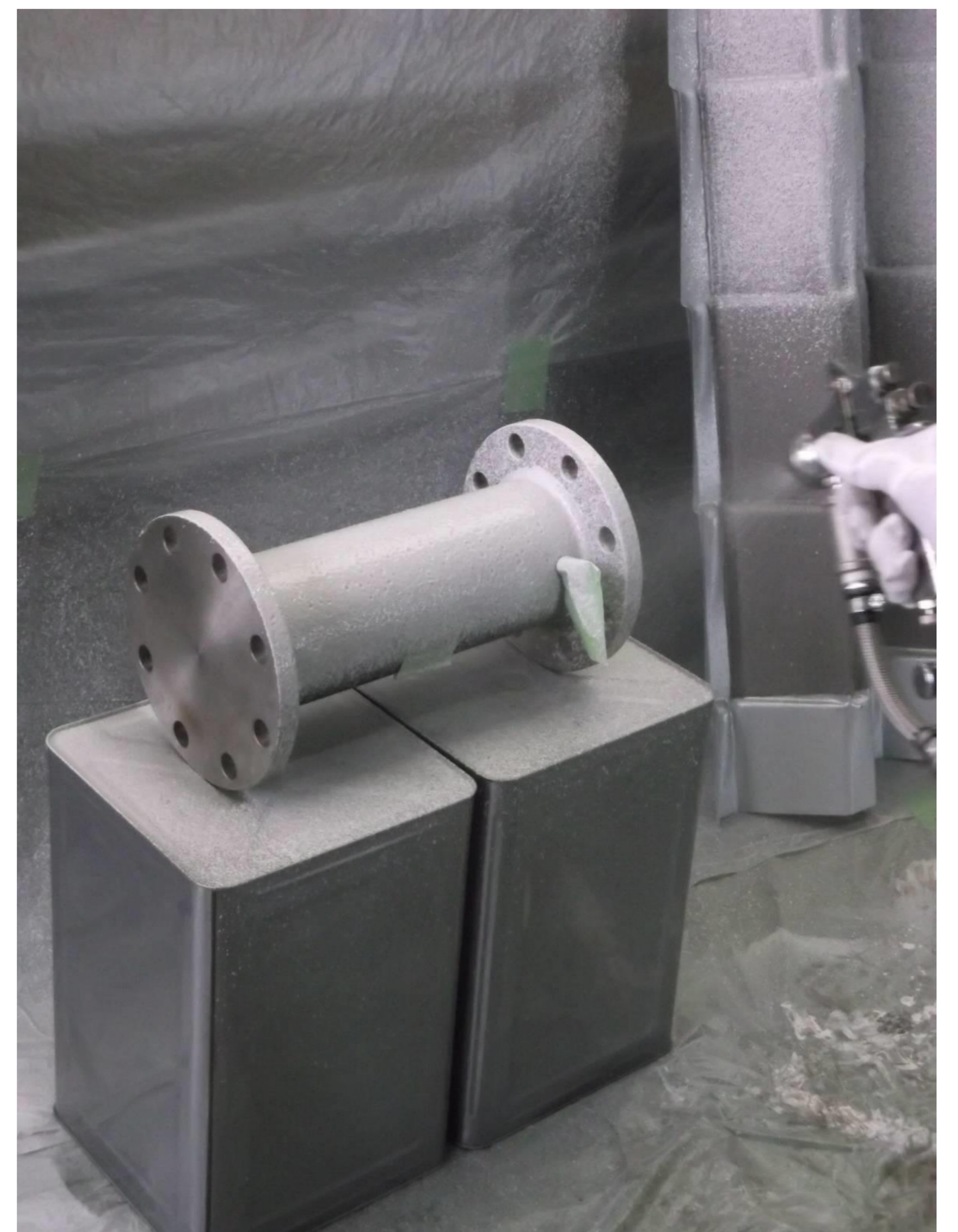
図-1 吹付施工
