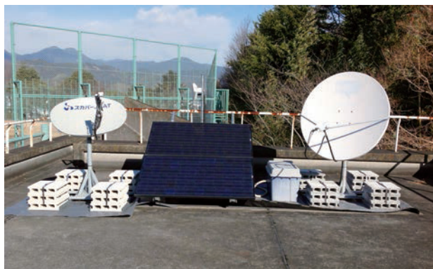
自立型防災通信ステーション
