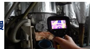
サーモカメラによる放熱部探索
